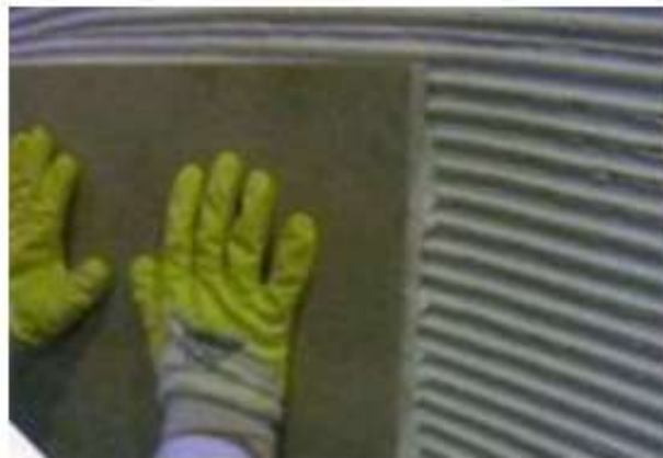
Aplicação de uma placa de pedra sobre o material de assentamento
