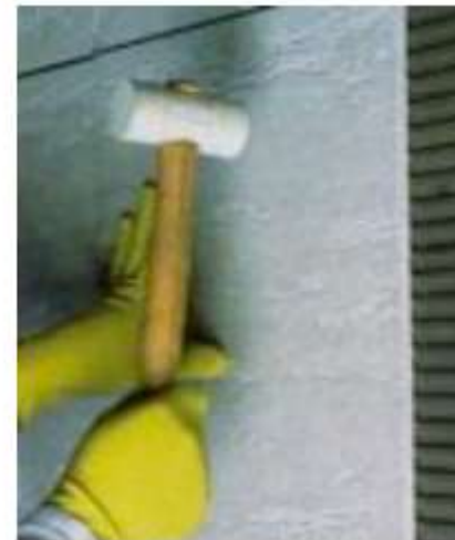
Placa de pedra aplicada e pressionada para garantir o esmagamento dos cordões de cola
