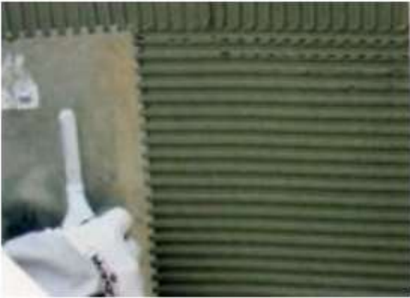
Aplicação do material de assentamento no suporte
